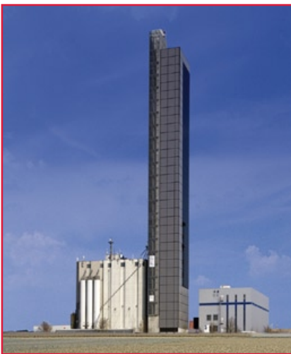
Photovoltaik Fassadenverkleidung Schapfenmühle, Baden Württemberg Photo: Würth Solar
