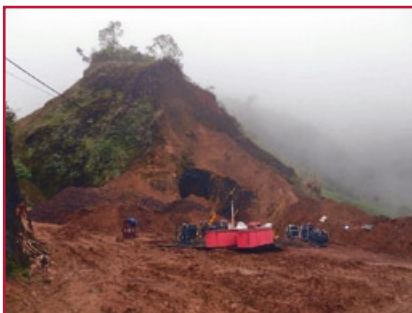
Ecuador: Aufbau eines Bohrturmes Photo: Canuc
