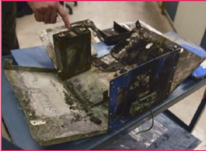
Ausgebrannte Li-Ionen Batterie Photo Japan today
